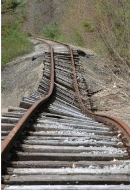
Aplica-se apenas para os corpos em estado sólido, e consiste na variação considerável de apenas uma dimensão. Como, por exemplo, em barras, cabos e fios. Ao considerarmos uma barra homogênea, por exemplo, de comprimento  $L_0$  a uma temperatura inicial  $\theta_0$ . Quando esta temperatura é aumentada até uma  $\theta > \theta_0$ , observa-se que esta barra passa a ter um comprimento  $L > L_0$ .
